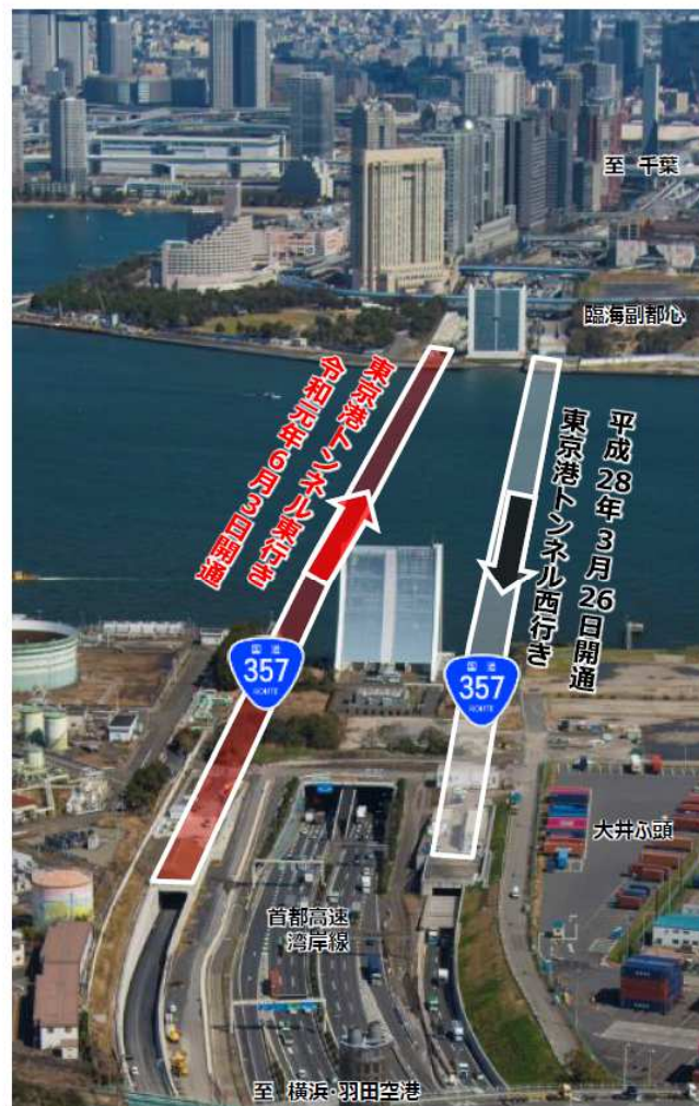
写真① 東京港トンネル全景
