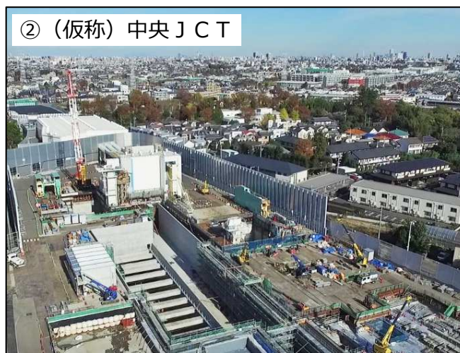
・ランプトンネルの発進立坑及びランプ部の工事等を実施中
