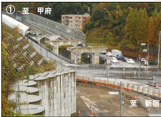
館高架橋 館町地区から甲府方向を望む【令和元年11月 撮影】
