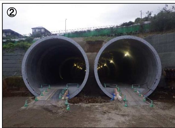
館第一トンネル甲府方面出入口【令和元年9月 撮影】
