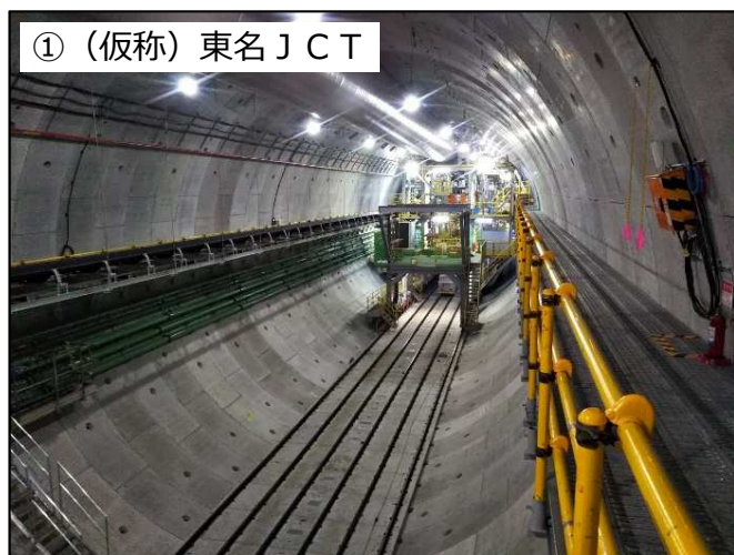
・本線トンネルの掘削及び施工基地の整備等を実施中
