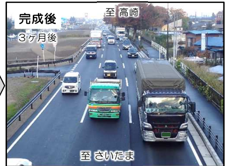
令和元年11月19日(火)7時台撮影
