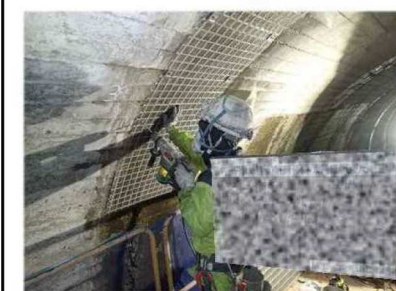
修繕の様子(剥落対策)
