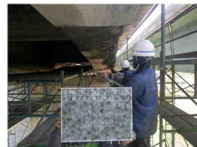
修繕の様子(断面修復)
