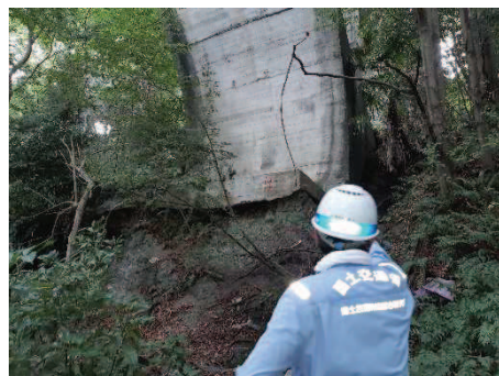
基礎地盤の状況確認
