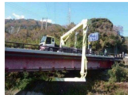
橋梁点検車による点検状況
