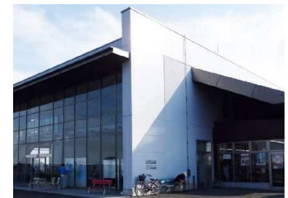
道の駅 はにゅう 防災ステーション内
