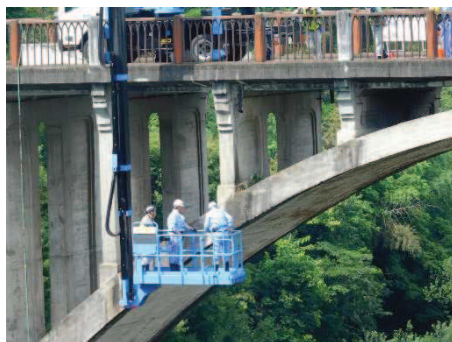
アーチ部材の形状の確認
