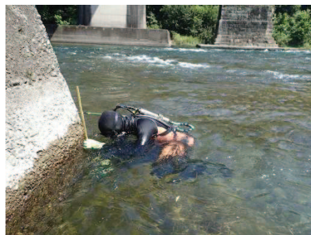
基礎の安定の確認
