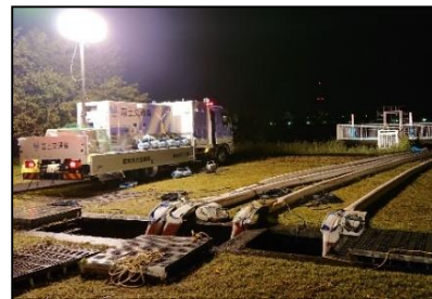
自治体要請による排水ポンプ車の派遣状況
