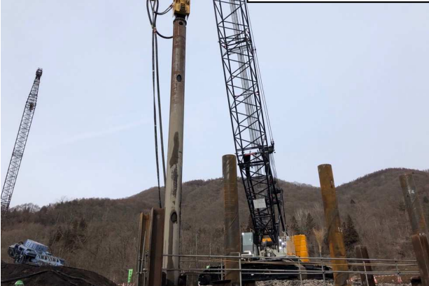
杭基礎工施工状況②
