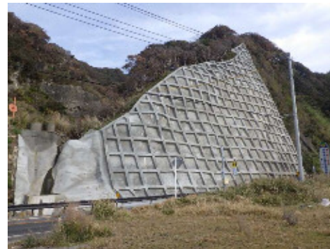
写真②:防災対策実施状況(H30)(富津市元名)
