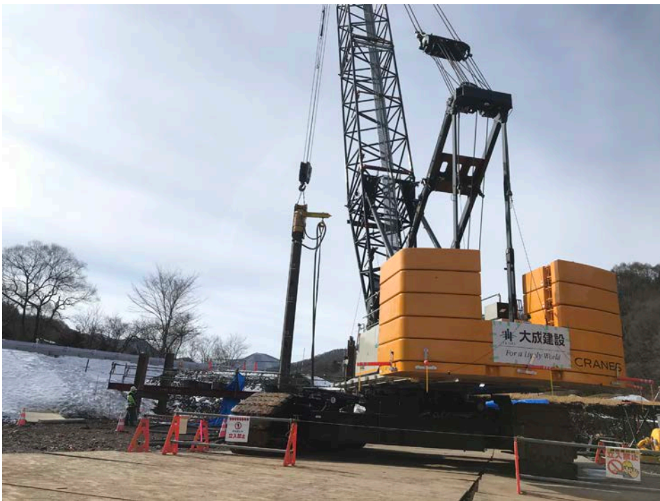
杭基礎工施工状況
