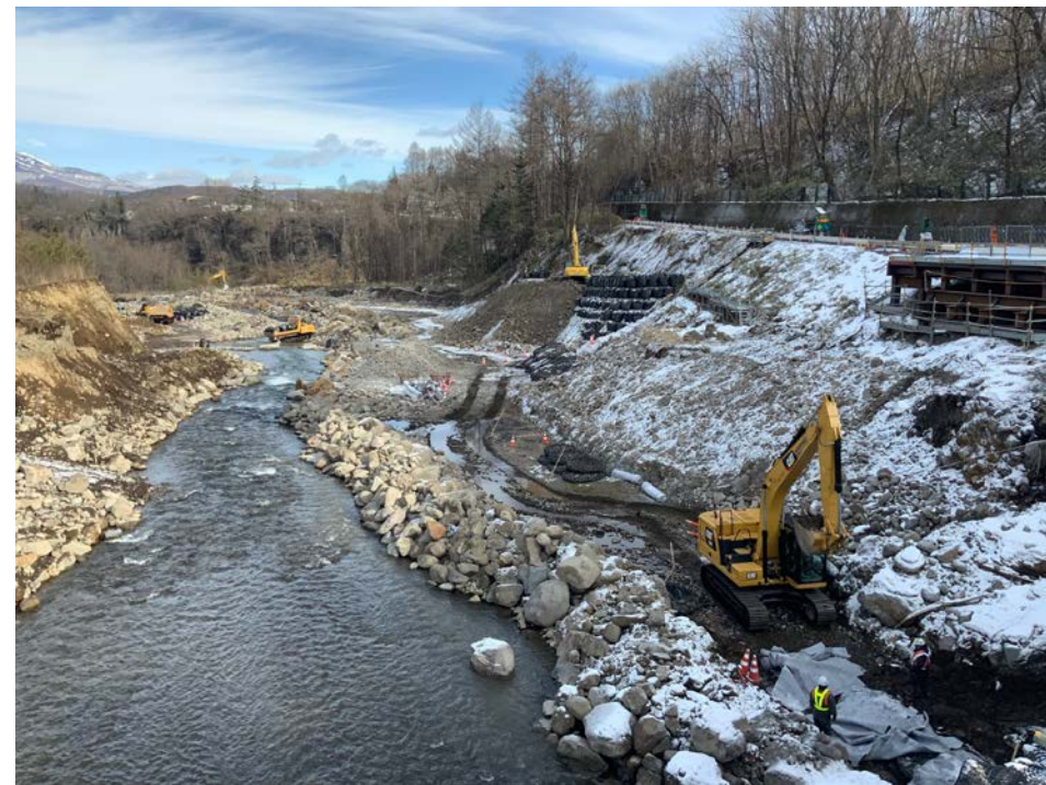
法面復旧工施工状況
