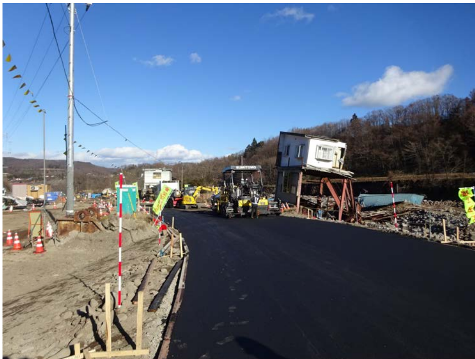
舗装工施工状況
