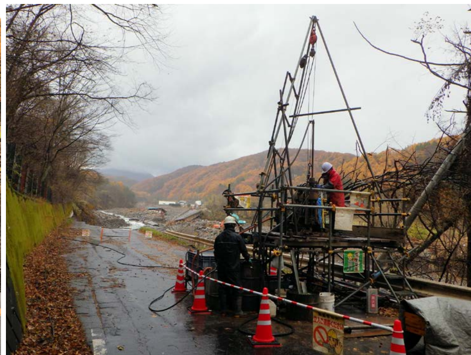
ボーリング調査状況
