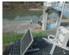
河川監視用CCTVカメラや 機器管理型水位計による観測
