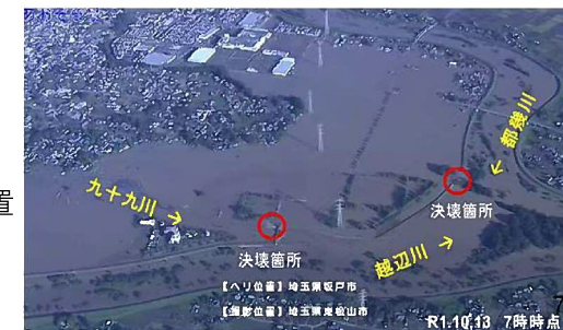
入間川流域における浸水被害状況
