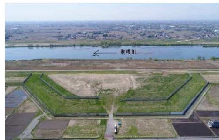
栄地区広域避難地(埼玉県加須市)
