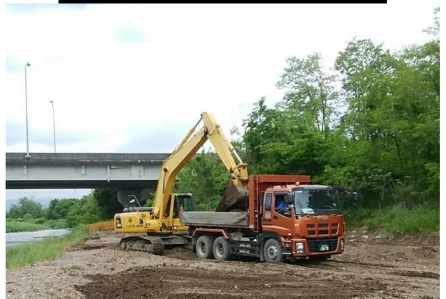
河道内の土砂掘削事例
