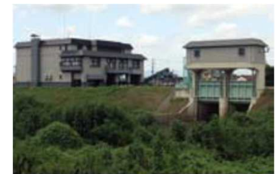
・九十川排水機場(川越市) ・平成15年設置 (最大排水能力20m 3 /s)
