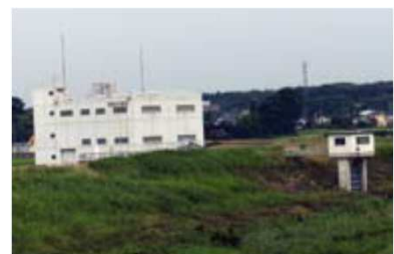
・岡排水機場(東松山市) ・昭和60年設置 (最大排水能力5m 3 /s)
