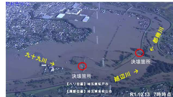
入間川流域における浸水被害状況
