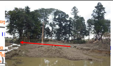
④倒木が堤内地側に倒れている
