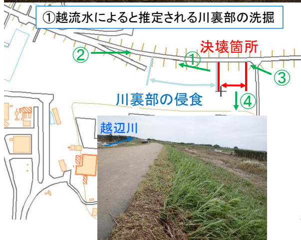
②川裏部の川裏側への植生の倒伏
