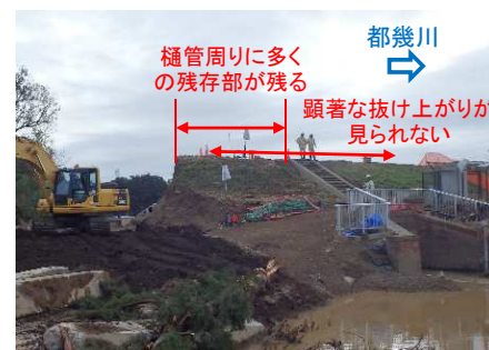
①樋管周りの残存部 （堤内地側より R1/10/16撮影）
