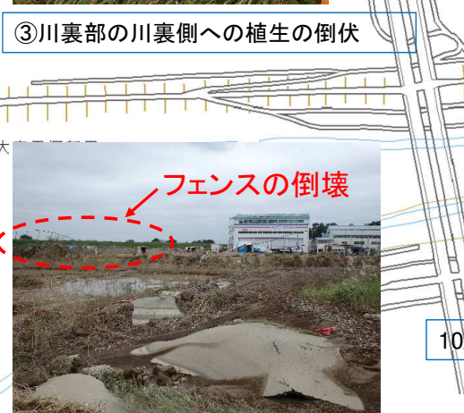
④フェンスの堤内地側への倒壊
