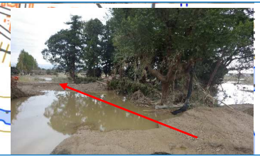
⑤倒木が堤内地側に倒れている
