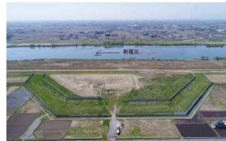
栄地区広域避難地(埼玉県加須市)
