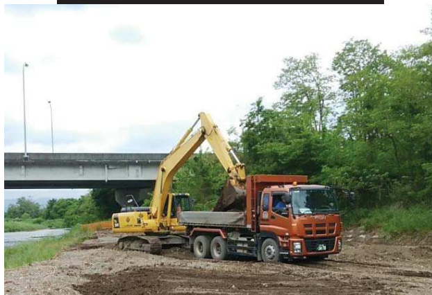
河道内の土砂掘削事例
