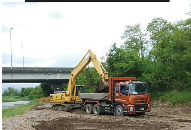
河道内の土砂掘削事例
