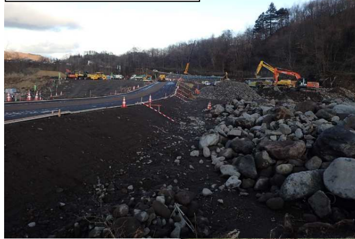
写真② 一般部盛土状況
