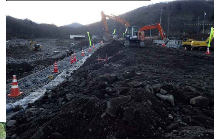
写真③ 終点側仮護岸復旧状況
