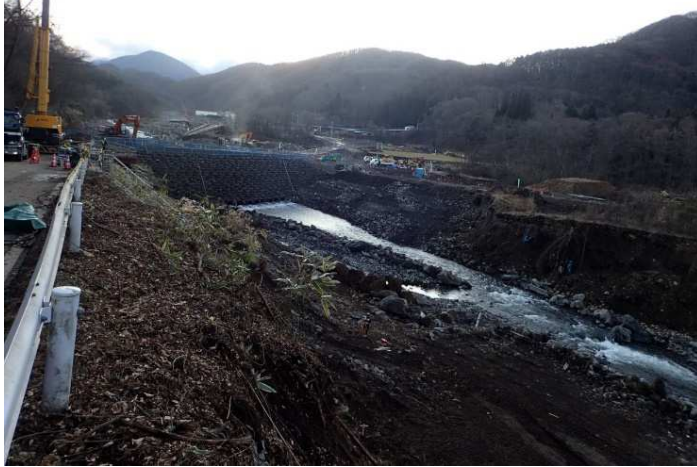
写真① 渡河部盛土状況
