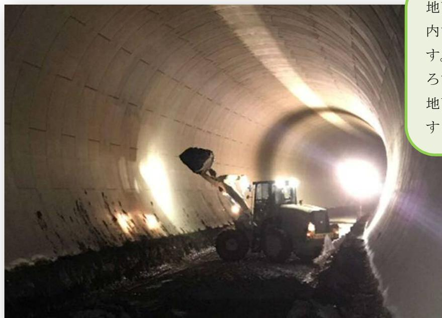
地下のトンネルは、直径10m。トンネル内で機械が方向転換するのも一苦労です。トンネルに入った土砂は、厚いところで1mを超えるほどたまっています。地下に取り込んだ川の水を適切に排水するためにも、重要な作業です。
