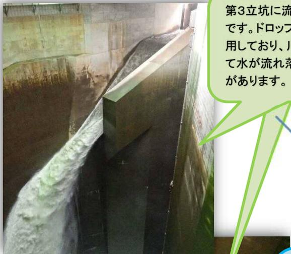
第3立坑に流入している様子です。ドロップシャフト方式を採用しており、川の水が壁に沿って水が流れ落ちる状況は迫力があります。
