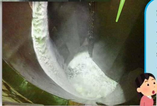
調圧水槽に水が流入する様子です。水が柱にあたり渦を巻いています(写真上)。調圧水槽に水がたまった状況です(写真下)。見学会開催時に施設内に水が流入した場合、管理用通路から流入した様子を見学できます。
