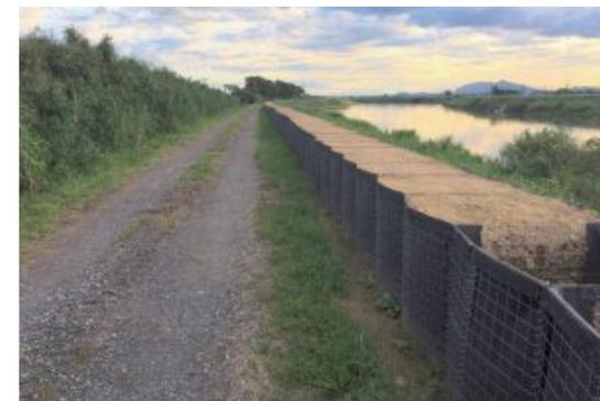
箱型鋼製枠による堤防嵩上げ工
