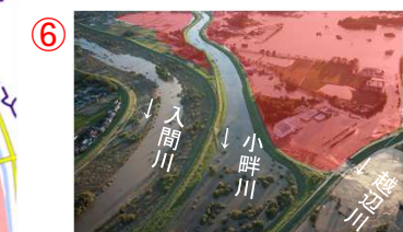
越辺川右岸0.0k付近
