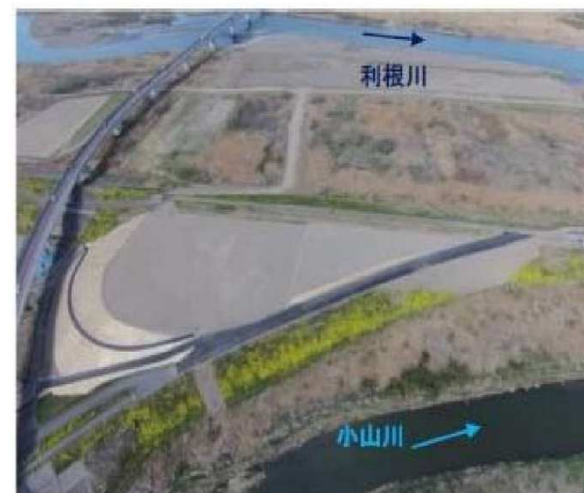
下高島地区(埼玉県深谷市)
