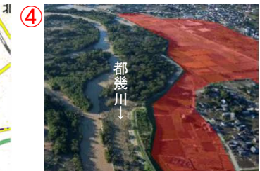
都幾川左岸6.5k付近
