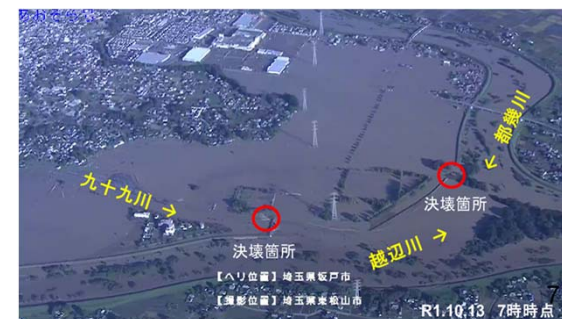
入間川流域における浸水被害状況
