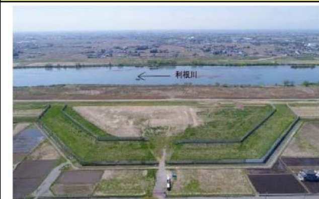
栄地区広域避難地(埼玉県加須市)
