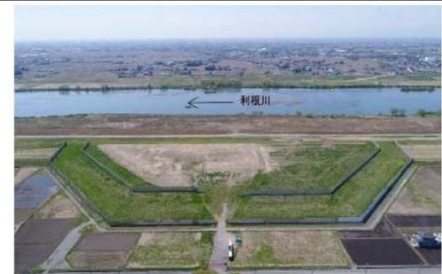
栄地区広域避難地(埼玉県加須市)
