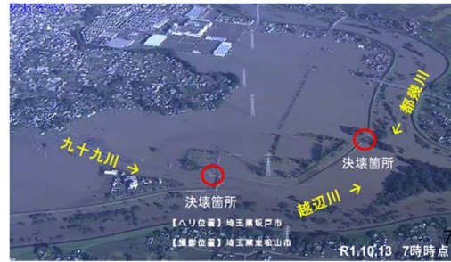
入間川流域における浸水被害状況
