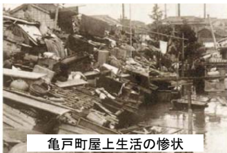
亀戸町屋上生活の惨状
