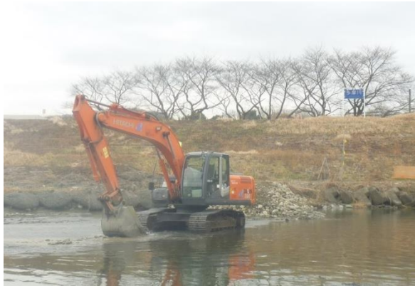
河道内の土砂掘削事例
