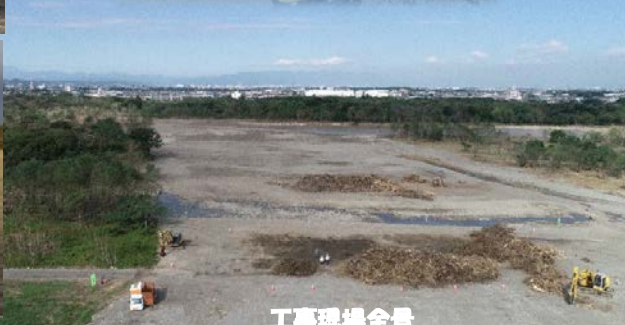
工事現場全景
