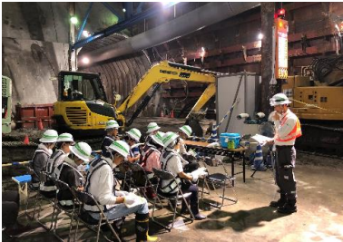
釜利谷ジャンクションCランプ工事 現場見学会の様子(H30.7)
