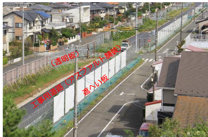
工事用道路にアスファルト舗装を実施
