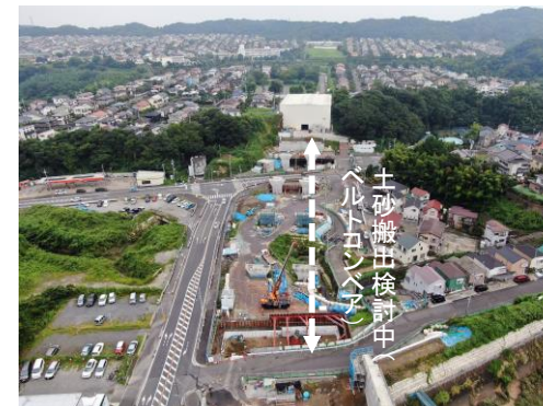
桂台トンネルの土砂搬出をベルトコンベアによる搬送を検討中
