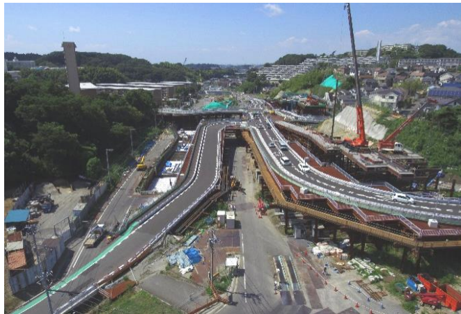
仮橋による付替道路を設置
