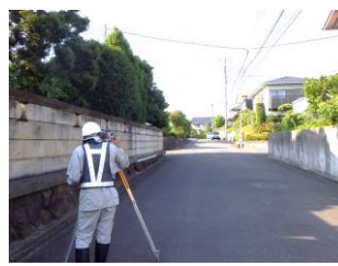
地表面変位観測状況
