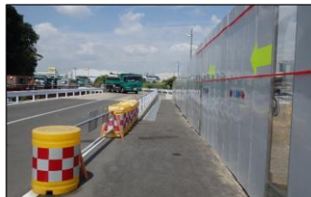
遮へい板の設置
