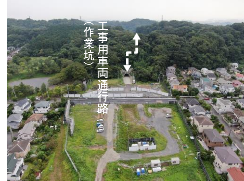
釜利谷JCTからの工事用車両通行路
