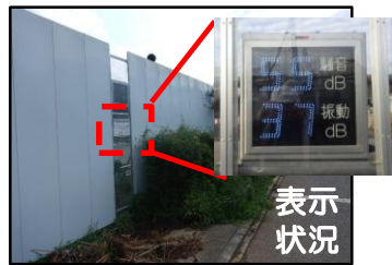
騒音計・振動計設置状況
