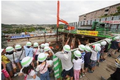
桂台トンネル工事における、沿線の小学生を対象とした現場見学の様子(H29.6)
