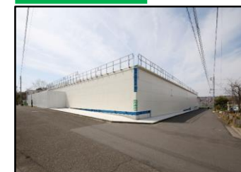
防音ハウスの設置
