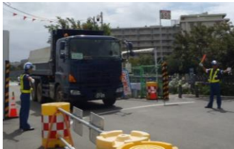
工事用出入口に誘導員を配置
