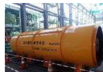
④大型ファン（風量3,000m³/min）
