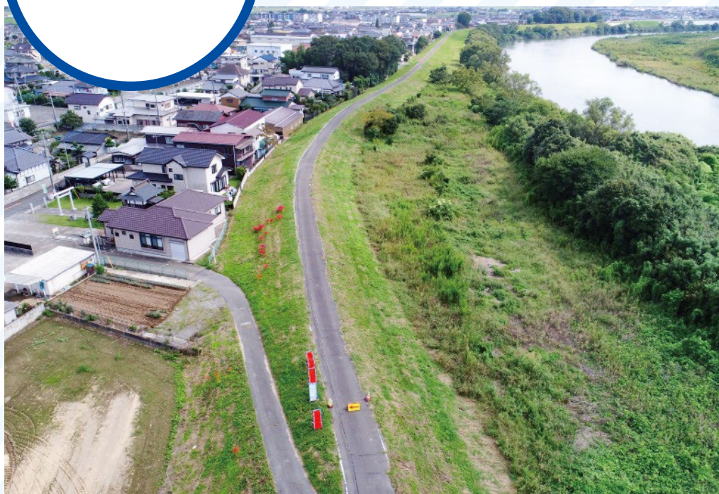
【施工前】2018年9月18日
