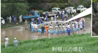
H13に利根川で発生した 基礎地盤からの大規模漏水
