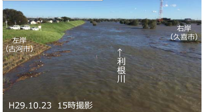
利根川栗橋地点（左岸）
