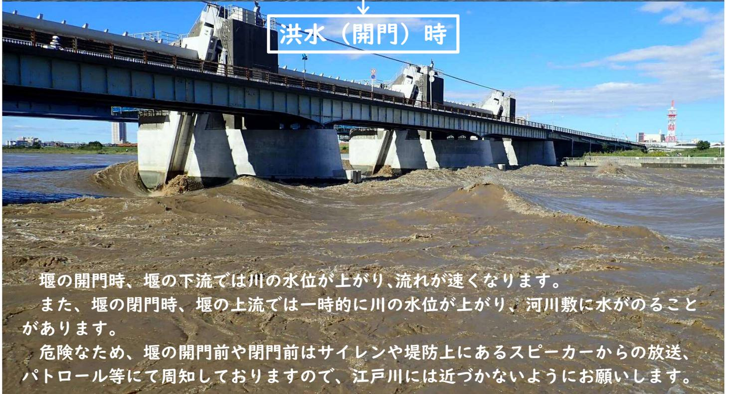
堰の開門時、堰の下流では川の水位が上がり、流れが速くなります。
