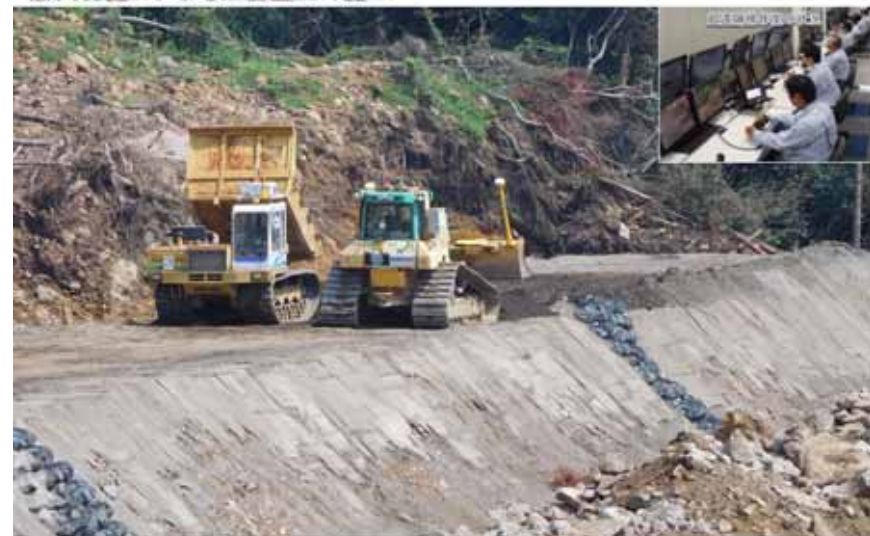
無人化施工による土留盛土の施工
