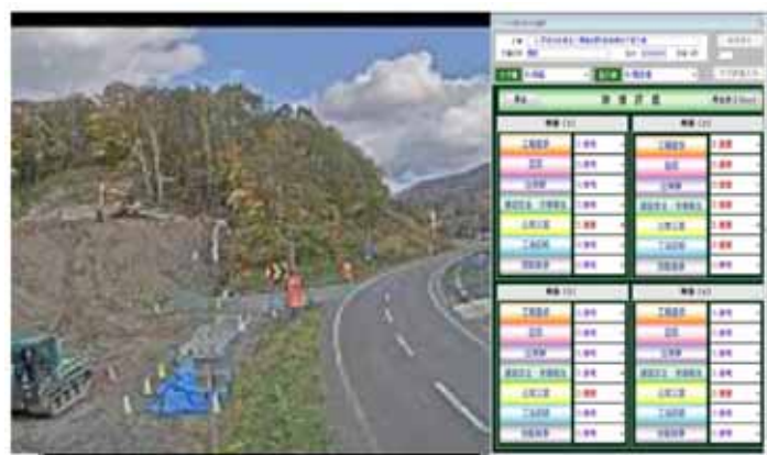
映像で建設現場の進捗を管理
