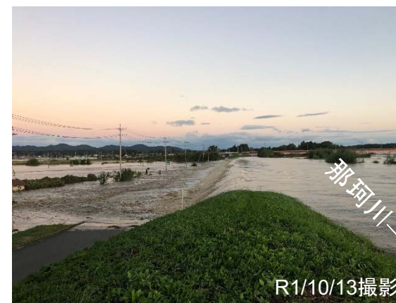
右岸28.6k(越水状況)
