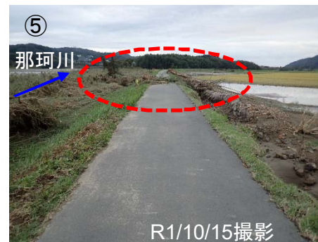
⑤⑥天端に越水による漂流物(流木)が残存している。
