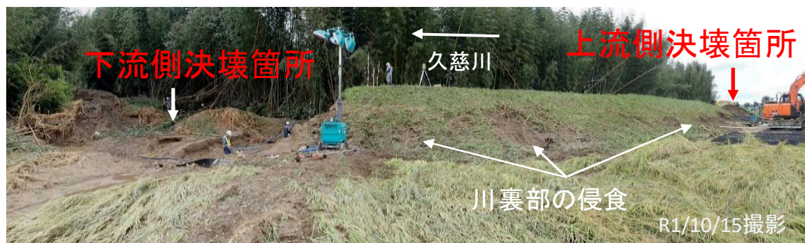
①上流側決壊箇所と下流側決壊箇所の残存部の川裏部に洗掘跡が見られる。
