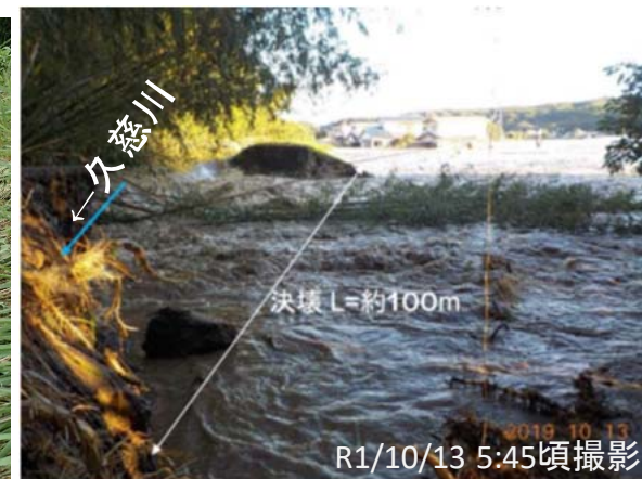
③決壊後の状況
