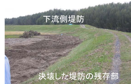
①上流から下流側の堤防を見た状況
