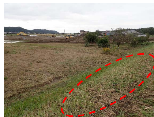
②天端から裏法にむかっの植生の倒伏が確認される (R1/10/15撮影)
