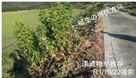
①川裏側法面の植生が川裏側に倒伏している。
