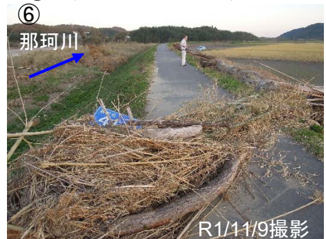
⑤⑥天端に越水による漂流物(流木)が残存している。
