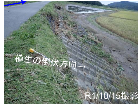
③川裏部の植生は川裏側に倒伏している。
