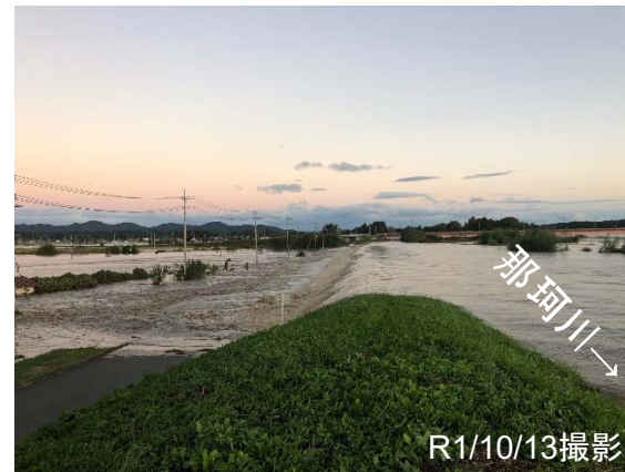
②越水状況
