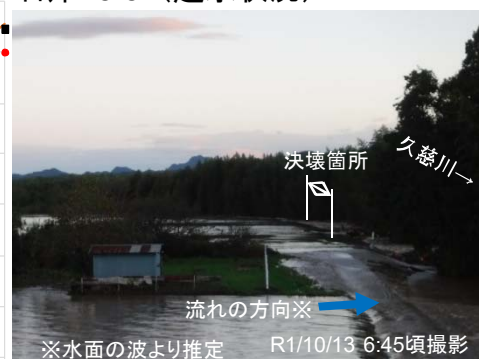
右岸25.5k(越水状況)
