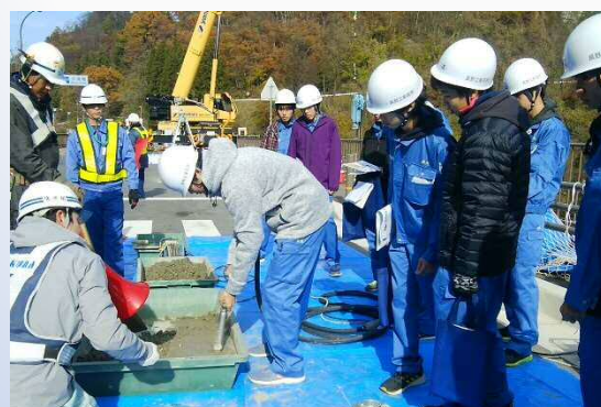
生コンクリート打設体験
