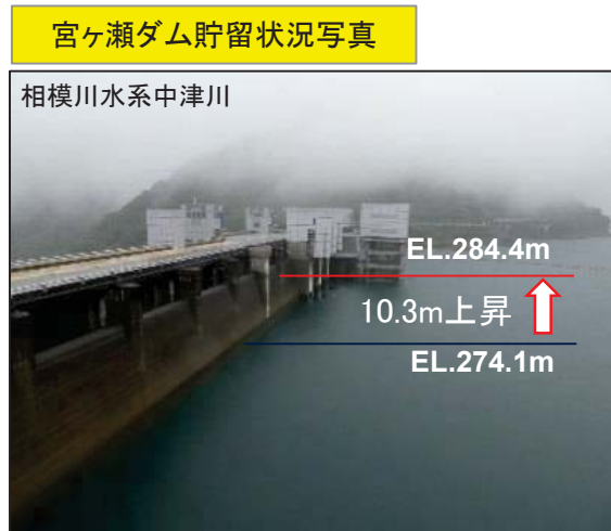
10月12日 8:00 状況写真
