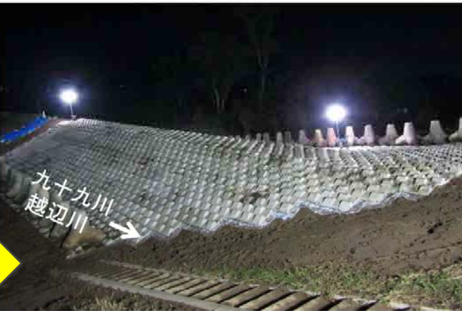
2019.10.19 21時20分時点 緊急復旧工事完了
