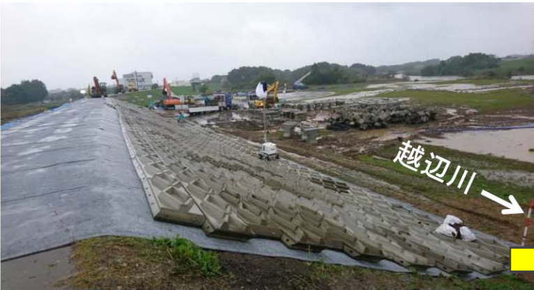
2019.10.22 8時00分時点 連節ブロック張施工中
