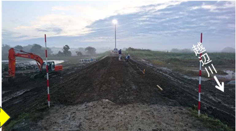
2019.10.20 8時00分時点 堤防盛土
