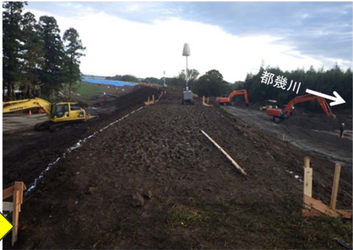
2019.10.20 8時00分時点 堤防盛土
