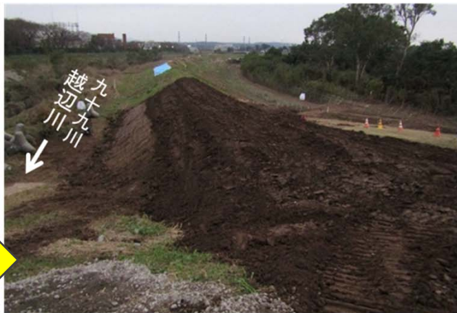
2019.10.17 8時00分時点 堤防盛土
