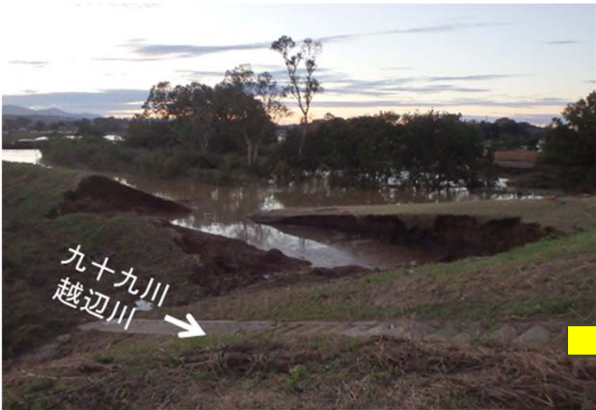
2019.10.13 17時30分時点 被災状況
