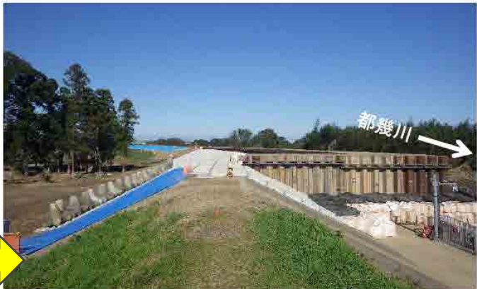
2019.11.8 13時00分時点 緊急復旧工事完了
