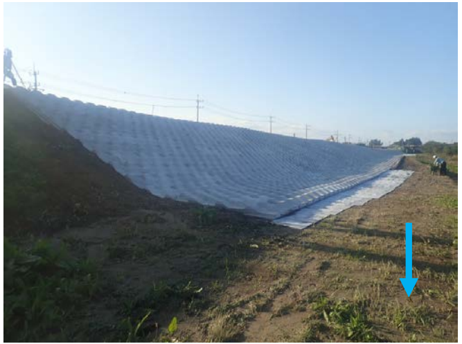
完成状況写真 2019.10.28 11時00分頃
