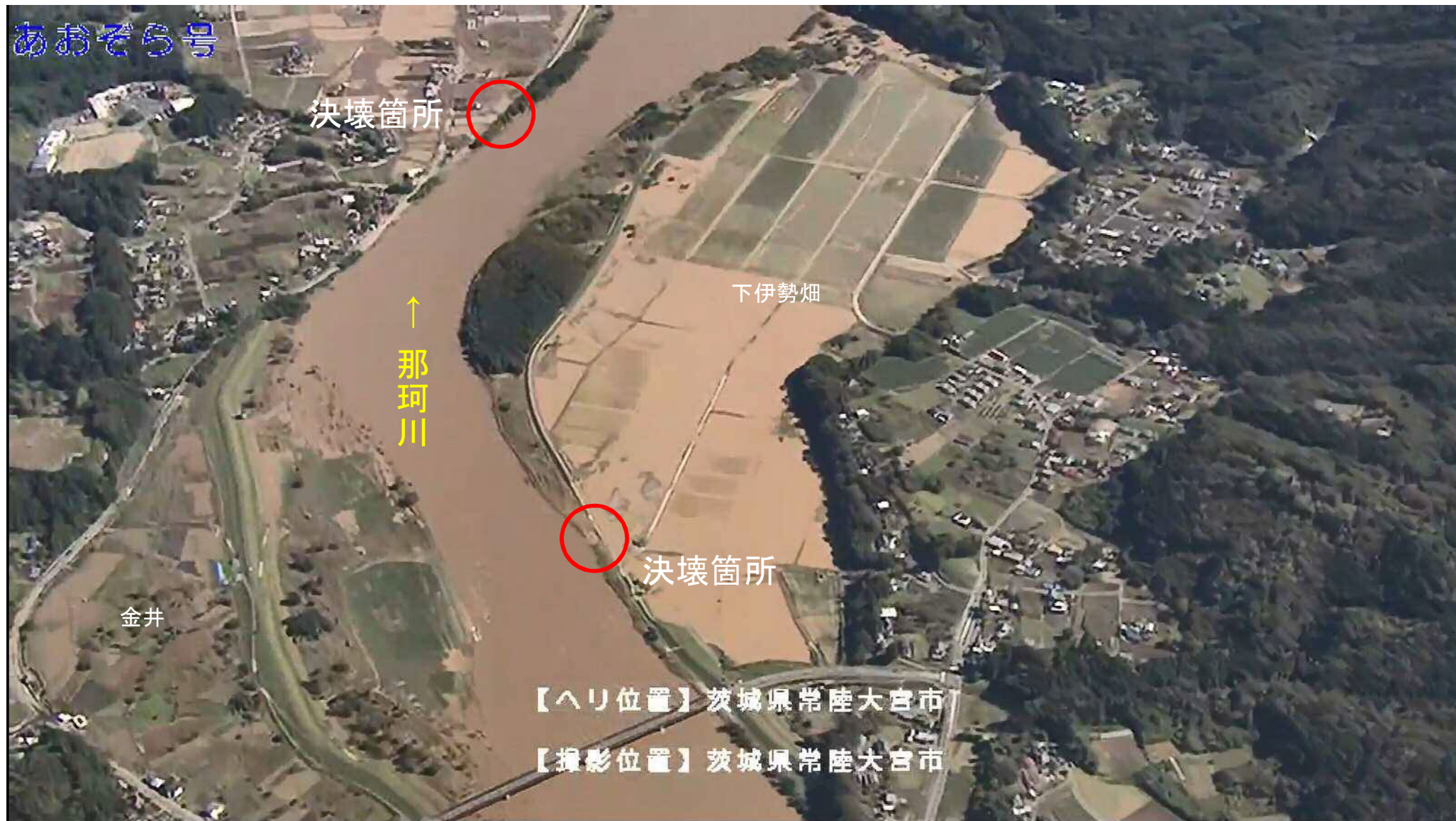
那珂川左岸40.0k、右岸41.2k
