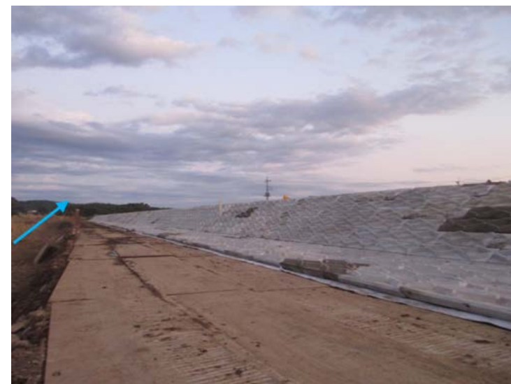
完成状況写真 2019.11.4 17時00分頃
