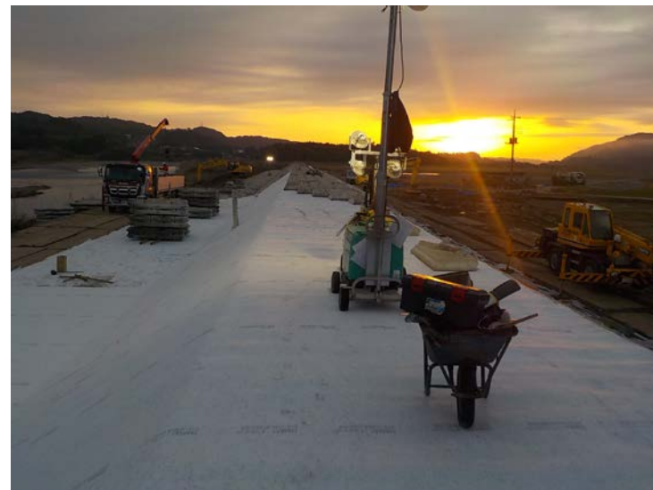
2019.11.3 7時00分頃 連節ブロック 施工中
