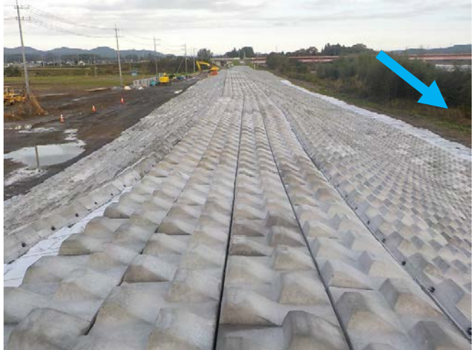
2019.10.28 7時00分頃 連節ブロック 施工中
