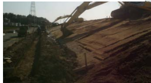
▲築堤工事の状況
