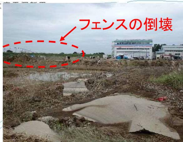
④フェンスの堤内地側への倒壊
