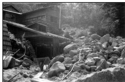
日光沢温泉の土石流被害 （昭和41年台風26号）
