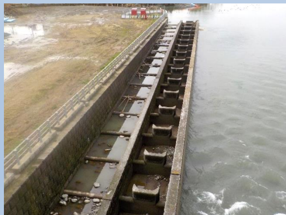
二ヶ領堰に設置されている魚道
