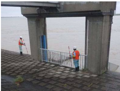
利根川下流河川事務所(状況把握班)による河川巡視 (10月14日(月)9:30頃 千葉県香取市津宮地先)
