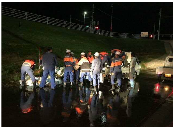
神崎町消防団による活動(利根川右岸51.0k付近) 令和元年10月13日(日) 21時頃 水防活動内容 : 月の輪工法(漏水対応) 2カ所 土のう 約300袋 活動延べ人員 40人
