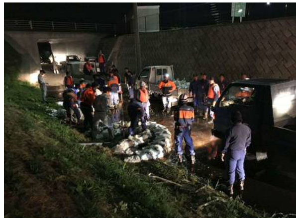
神崎町消防団による活動(利根川右岸51.0k付近) 令和元年10月13日(日) 21時頃 水防活動内容 : 月の輪工法(漏水対応) 2カ所 土のう 約300袋 活動延べ人員 40人
