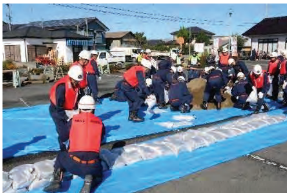
平成30年11月10日(大宮地域) 防災訓練による「改良積み土のう工法」
