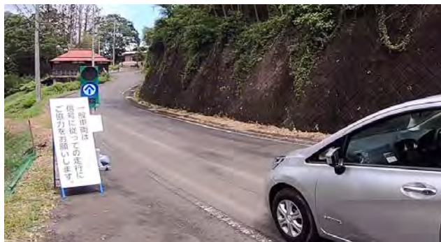
仮設信号の設置状況
