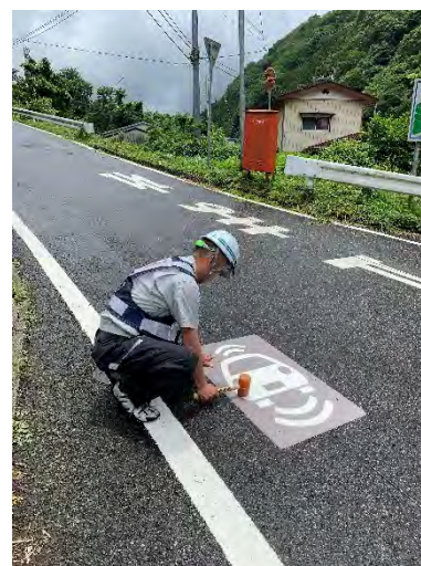
路面標示の施工
