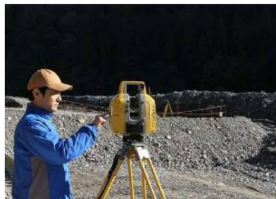
レーザースキャナーによる測量
