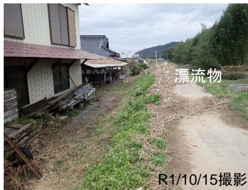
③天端に越水による漂流物(流木)が残存している。
