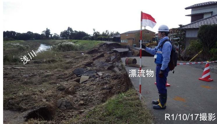
①川表部が侵食、流出している。天端には越水による漂流物が残存している。
