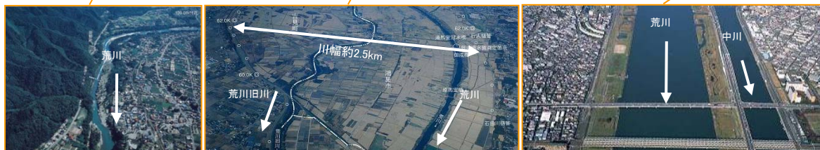
◆上流部：山間部の状況
