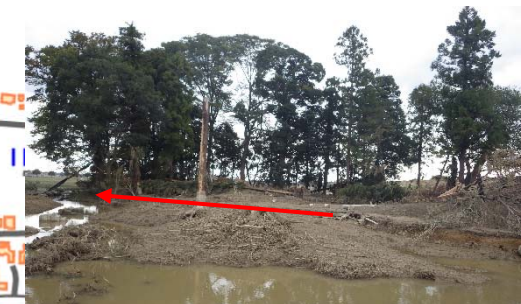
④倒木が堤内地側に倒れている
