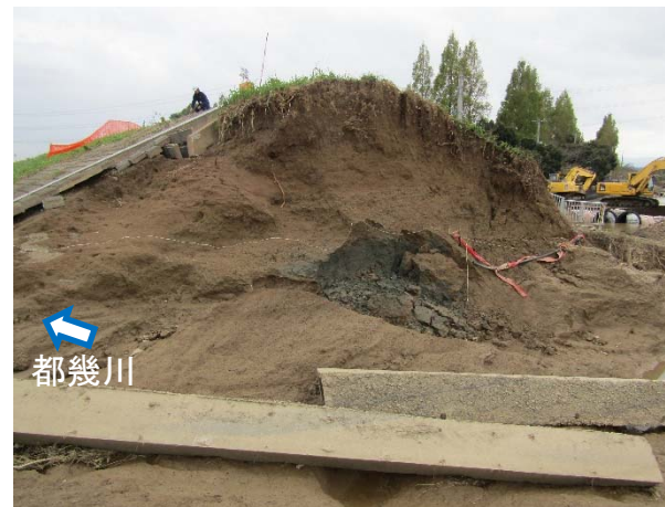
③樋管周りの残存部 (下流側断面 R1/10/15撮影)
