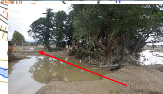
⑤倒木が堤内地側に倒れている
