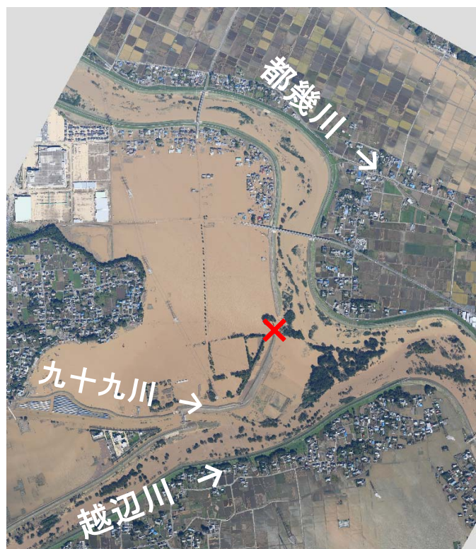
国土地理院撮影 都幾川地区の垂直写真(速報)(R1/10/13撮影)
