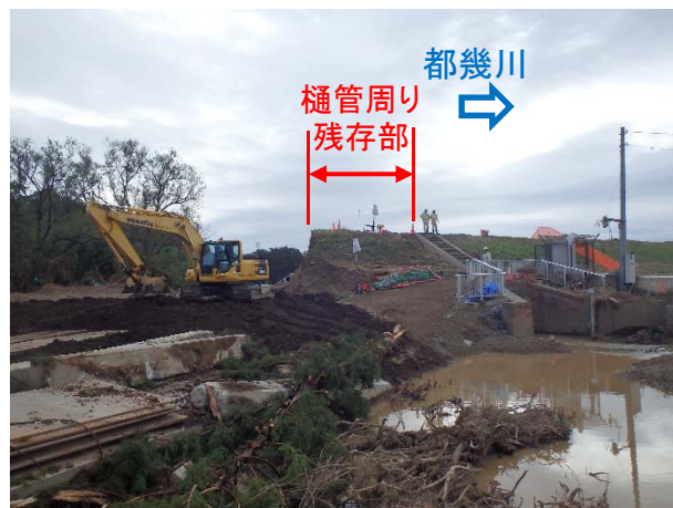
①樋管周りの残存部 (堤内地側より R1/10/16撮影)
