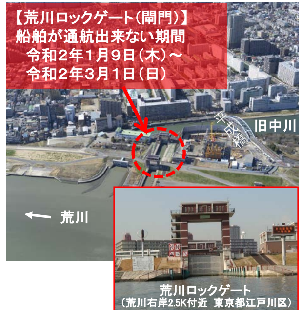
【荒川ロックゲート周辺写真】
