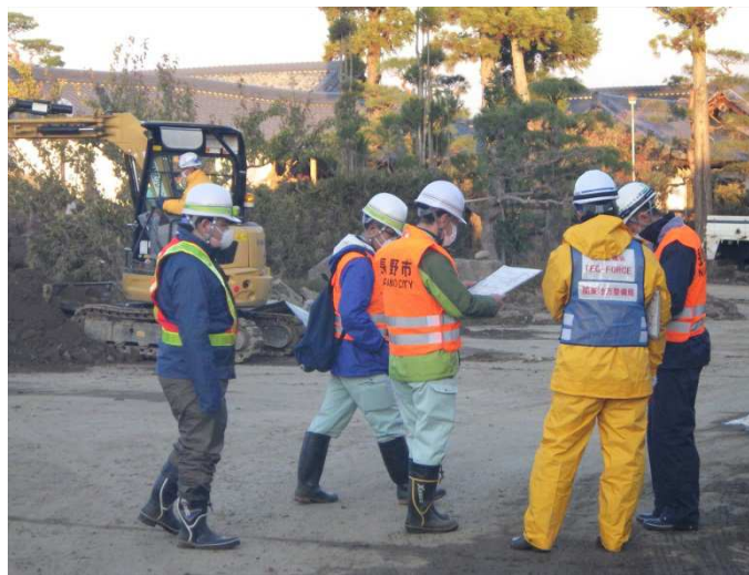
路面清掃について現地打合(長野県長野市)
