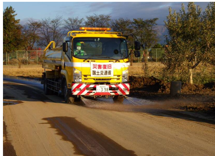
散水車による路面清掃(長野県長野市)
