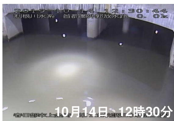
第1立坑から調圧水槽への流入状況
