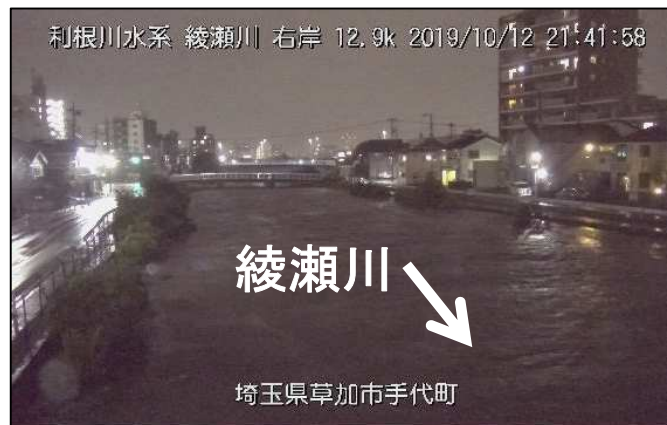
綾瀬川出水状況(埼玉県草加市付近)
