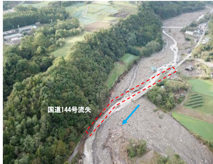
嬭恋村大笹地区の被災状況(吾妻川)
